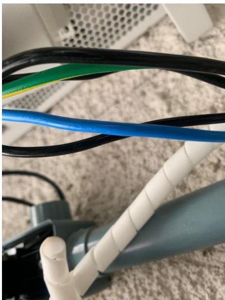
*cabeamento dos inversores de 12kw sem normativa
