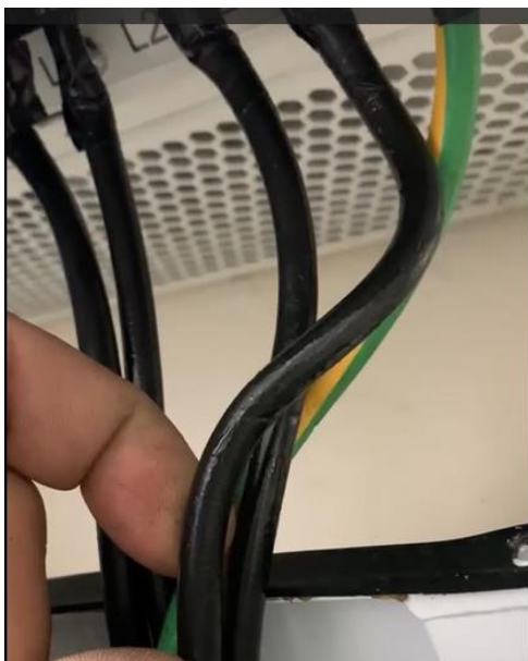
*cabeamento dos inversores de 30kw apresentado sinal de alta temperatura
