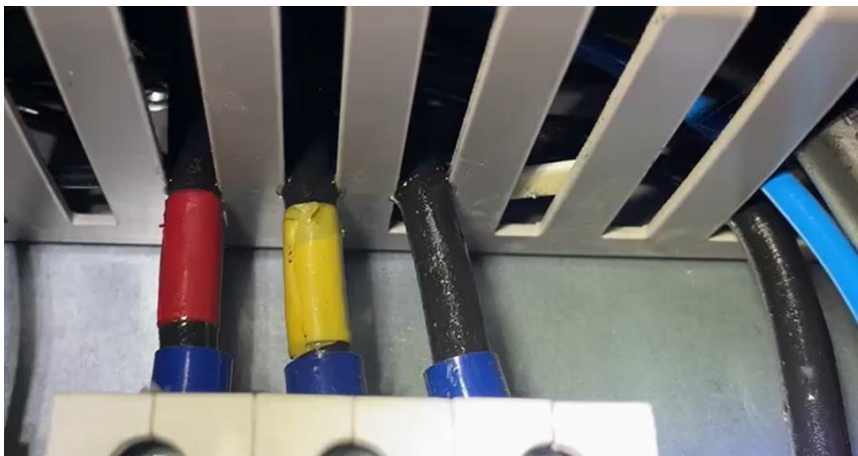
*cabeamento dos inversores de 30kw apresentado sinal de alta temperatura
