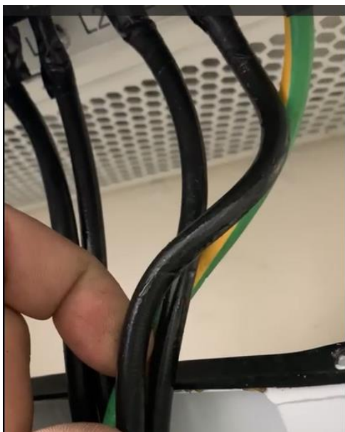
*cabeamento dos inversores de 30kw apresentado sinal de alta temperatura
