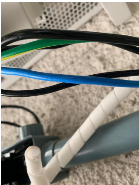
*cabeamento dos inversores de 12kw sem normativa
