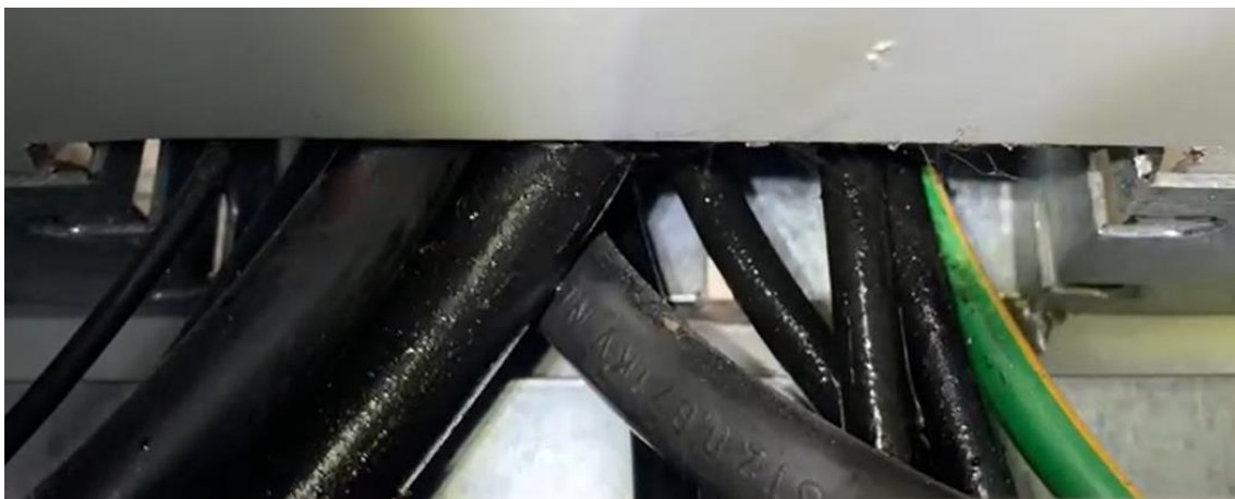
* cabeamento dos inversores de 30kw e 60kw apresentado sinal de alta temperatura
