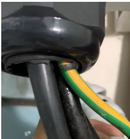
* cabeamento dos inversores de 60kw apresentado sinal de alta temperatura
