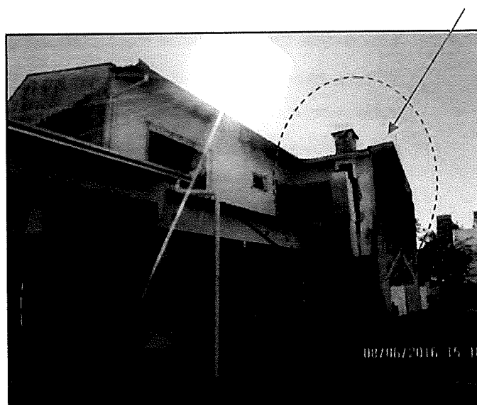
Figura 5. Casa com rachaduras depois do subsolo interdita pela Defesa Civil
