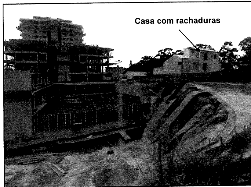
Figura 4. Escavação dos fundos do terreno do empreendimento.
